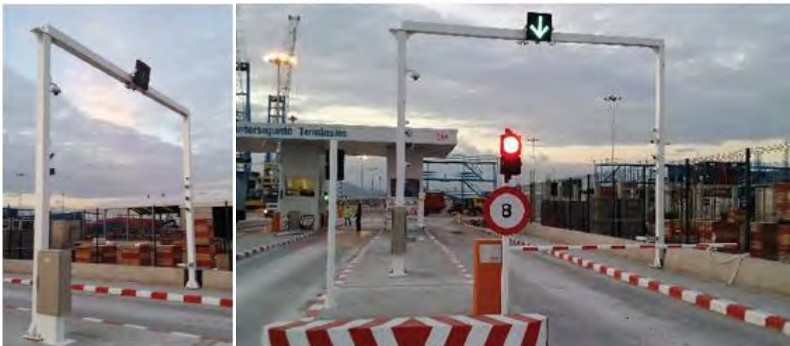
Fig. 2 Pórtico de Lectura de contenedores.
